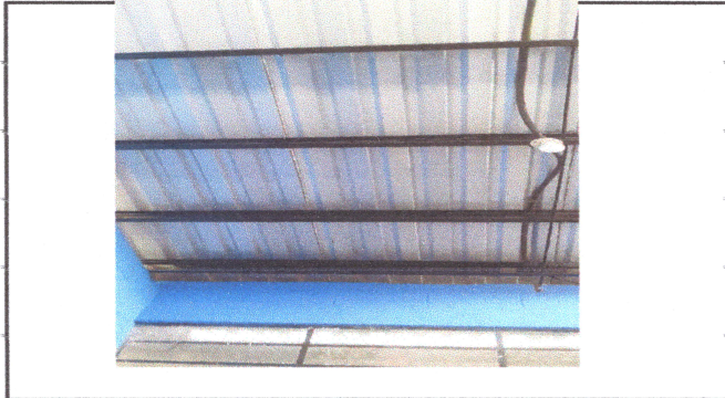
Foto1: TECHO NUEVO DEL EDIFICIO
