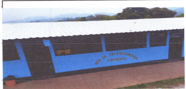
Foto 2: PINTURA Y TECHO DE SANITARIOS
