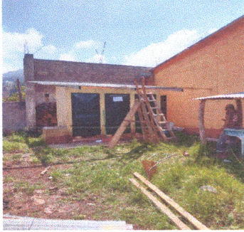
Foto 1: CAMBIO DE TECHO DE SANITARIOS
