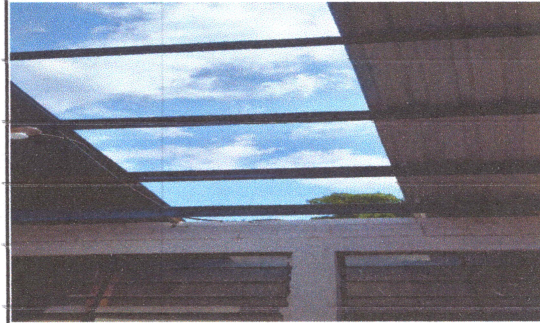
Foto 2: CAMBIO DE TECHO DE EDIFICIO ESCOLAR
