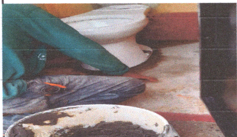
Foto 3: CAMBIO DE SANITARIOS
