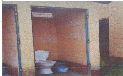
Foto 4: CAMBIO PUERTAS DE SANITARIOS
