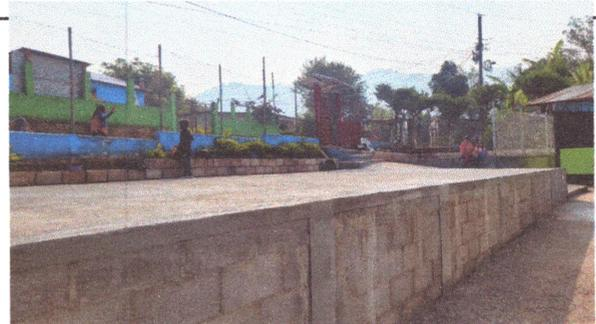
Foto4: Sustitución de Losa de Patio pues se encontraba casi en su totalidad deteriorada
