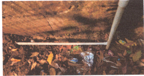
FOTO 2: Reparación de tuberías a sanitarios dañados
