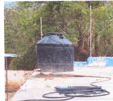
Foto: 6 Reparación de tubera de Deposito de Agua
