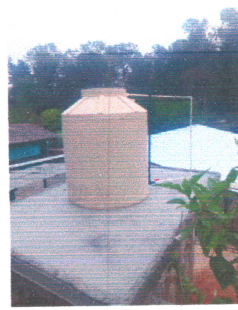
FOTO 8: Reparación y mantenimiento de cisterna de agua
