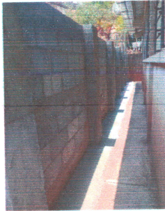
Foto 9: Reparación y ampliación de muro de contención
