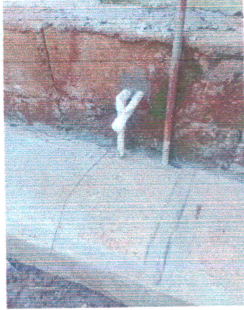
Foto7: Reparación de drenajes y red de agua potable
