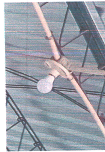
Foto 10: Reparación de sistema eléctrico
