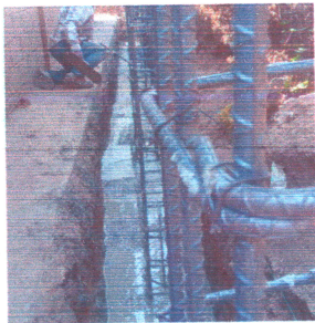
Foto 9: Reparación y ampliación de muro de contención
