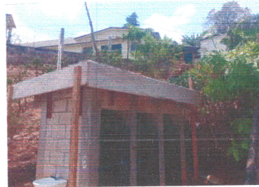
FOTO 8: Reparación y mantenimiento de cisterna de agua
