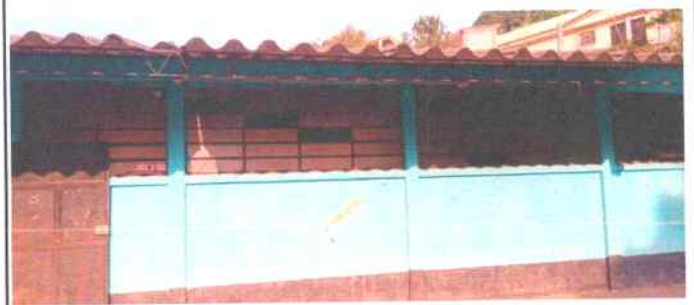
Foto 4: Reparación de canales
