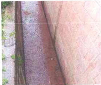
Foto 9: Reparación y ampliación de muro de contención
