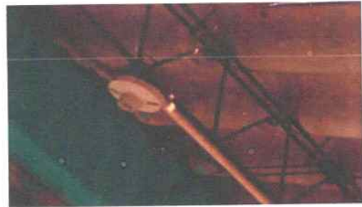
Foto 10: Reparación de sistema eléctrico
