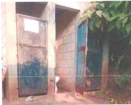
Foto: 5 Reparación y mantenimiento a sanitarios
