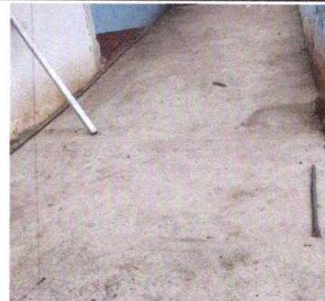
Foto 6: fundicion de la rampa finalizado
