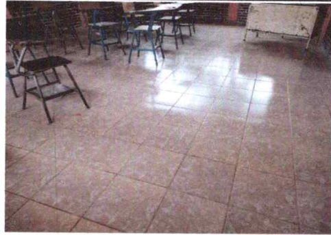
Foto 2: colocacion piso en las aulas finalizado
