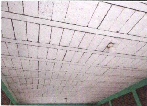
Foto 3: tratamiento en Terraza dañada finalizado
