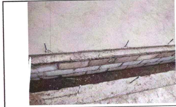
Foto 6: en proceso fundición de rampa
