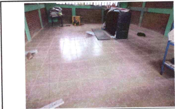
Foto 2: en proceso colocación de piso de las aulas.
