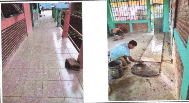
Foto 1: en proceso colocación de cerámica
