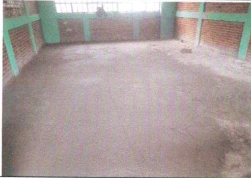
Foto1: Las aulas listas para colocarles la ceramica
