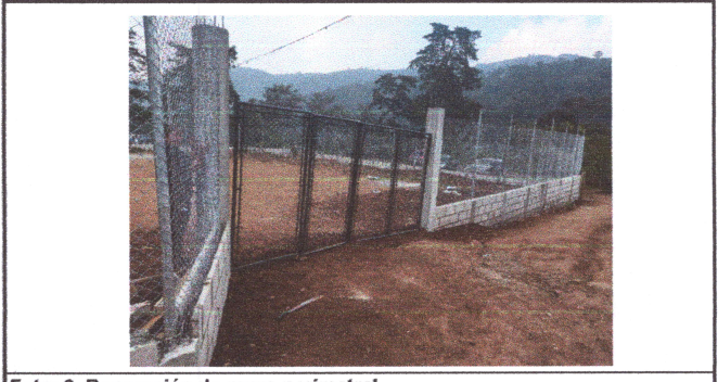
Foto 6: Reparación de muro perimetral
