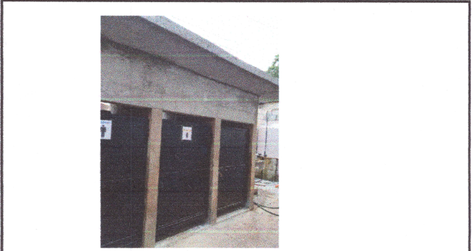
FOTO 2: Sustitución de lámina para puertas y reubicación
