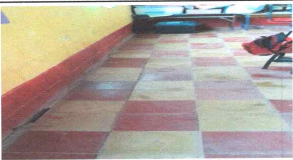
Foto 7: Sustrución de piso en aula, ya que hay un hundimiento en todo el piso
