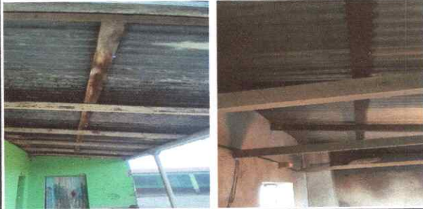
Foto1: Sustitución de cubieeta de lamina en cocina
