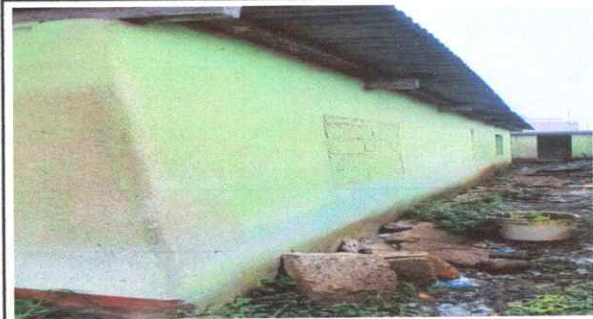
Foto 4: Reparación de repello y cernido en paredes
