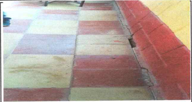
Foto 8 : Sustrución de piso en aula ya que hay un hundimiento en todo el piso
