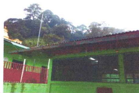
Foto 6: Cambio de canales
