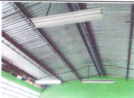
Foto 5: Reparación sistema eléctrico
