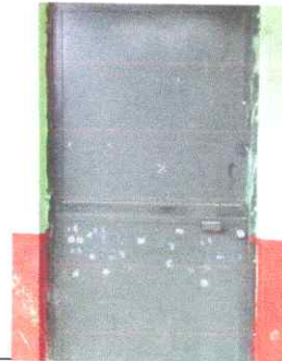
Foto 4: Reparación de chapas
