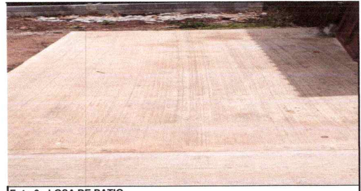
Foto 6: LOSA DE PATIO trabajo de losa de patio finalizado
