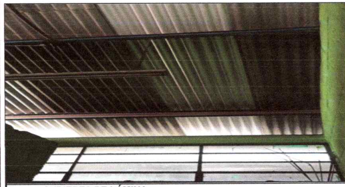
Foto 5: CUBIERTA DE LÁMINA trabajo finalizado en su totalidad
