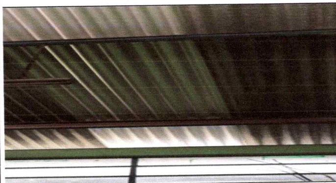
Foto 5: CUBIERTA DE LAMINA se observa trabajo en un 80%
