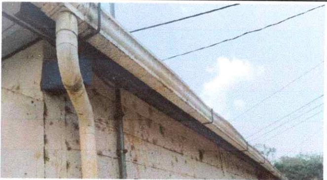
Foto 3: SUSTITUCIÓN DE CANALES Y BAJADAS 4"
