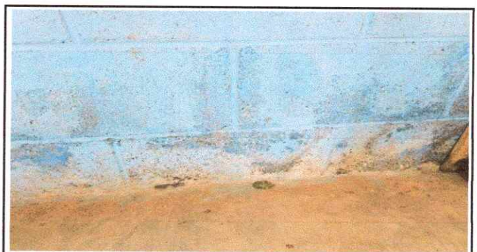
Foto 6: SUSTITUCION DE PINTURA BASE ACEITE (ZOCALO)
