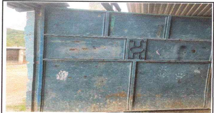
Foto 4: SUSTITUCIÓN DE PORTON DE TUBO CON LAMINA LISA
