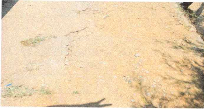
Foto 1: SUSTITUCIÓN LOSA DE PATIO INCLUYE BASE, FUNDICIÓN Y ACABADO
