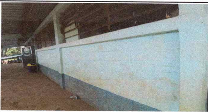
Foto 5: SUSTITUCION DE PINTURA BASE AGUA
