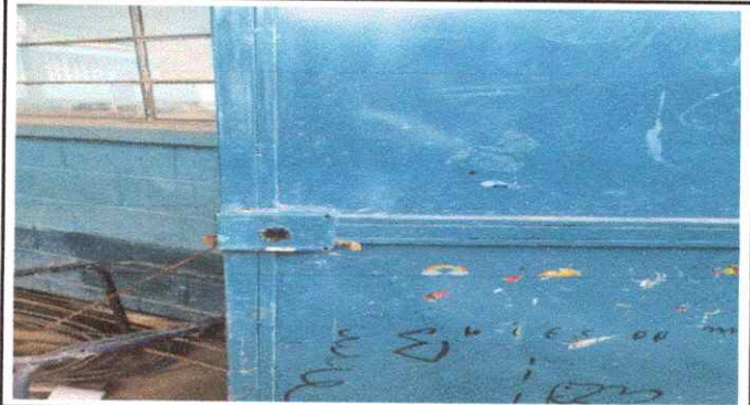
Foto 2: MANTENIMIENTO DE PUERTAS
