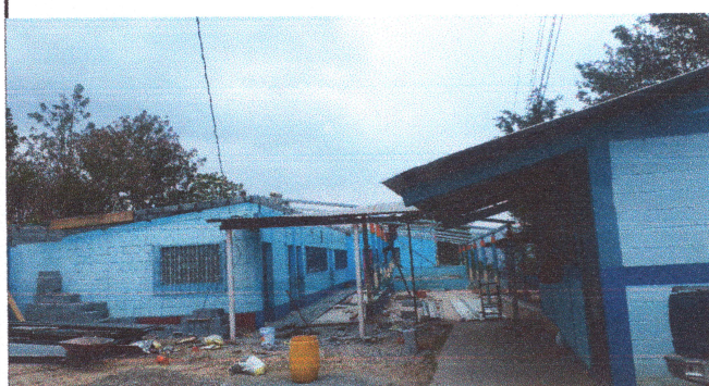
Foto: 6 Reparación de Sistema eléctrico
