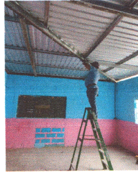
FOTO 2: Reparación sistema eléctrico
