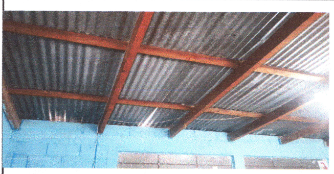
Foto1: Reparación estructura de techo
