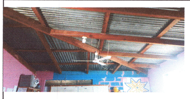
FOTO 2: Reparación sistema eléctrico
