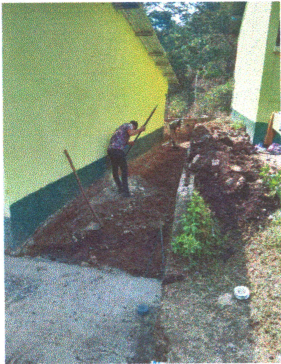
Foto3: Reemplazo de losa en mal estado.
