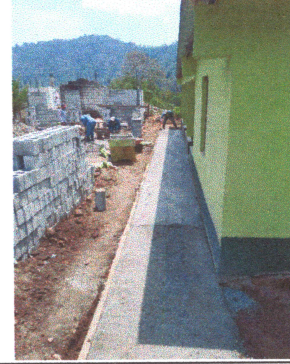
Foto4: Proceso de fundición de losa en los alrededores de aulas.
