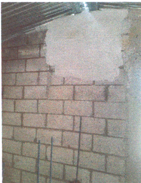
Foto 9: Sustitución del cernido de la cocina.
