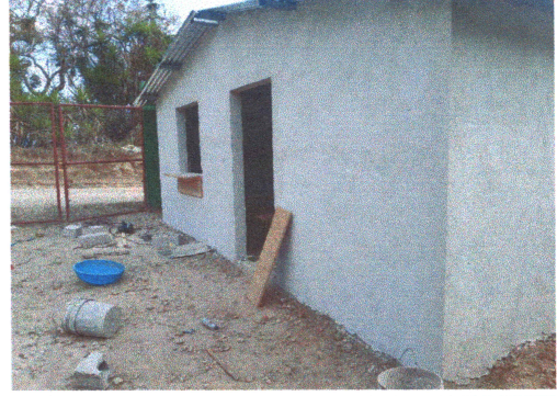
FOTO 8: Colocación de bases para las ventanas y puerta.
