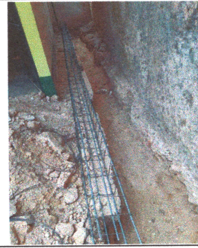
Foto: 6 Colocación de estructura de hierro para la base de soportes a muro de contención.
