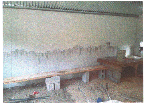
Foto 10: Proceso de sustitución de cernido.
