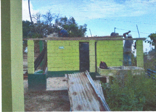
Foto1: Demolición de techo de cocina.
