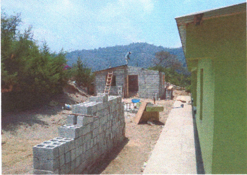
Foto 7: Colocación del techo al area de cocina que se remodeló.
