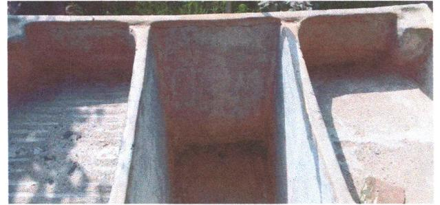
Foto4: Sustrucción de pilas, que presentan un alto grado de deterioro.
