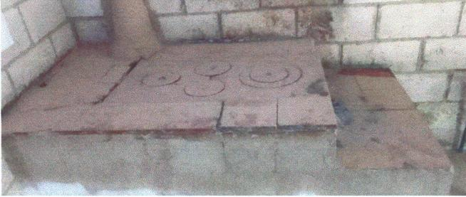
Foto1: Sustrucción de estufas rurales en mal estado.
