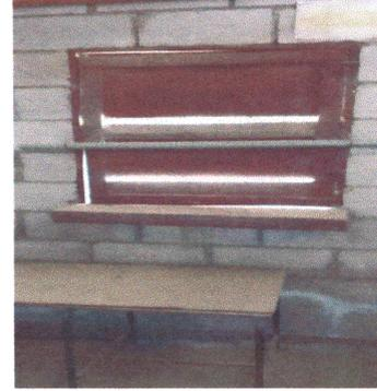
FOTO 2: Sustrucción de ventana de cocina en mal estado.
