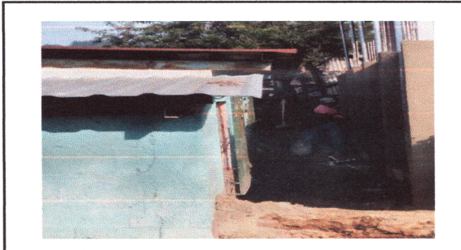
Foto3: Ultimos detalles a la reconstruccion del muro
