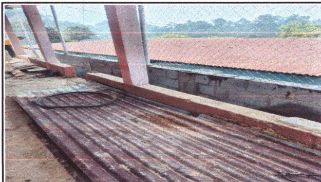
FOTO 2: Fundición de la malla
