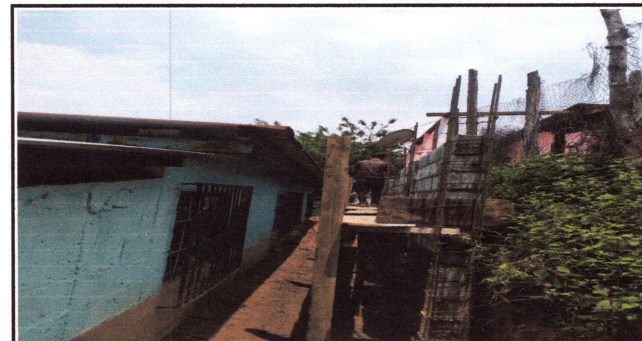
Foto: 6 Reconstrucción de muro.
