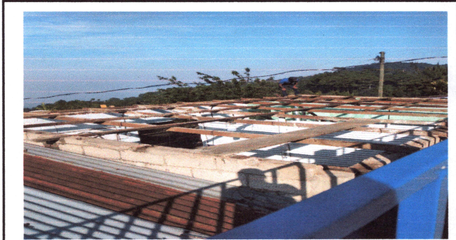
Foto1: Retirando la lamina vieja.
