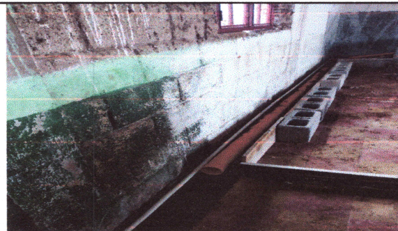
Foto: 6 Instalacion de tubos.
