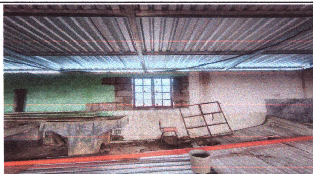
Foto: 5 Instalando ventanas
