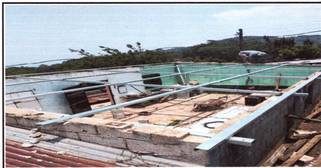
Foto3: colocación de estructura metalica.
