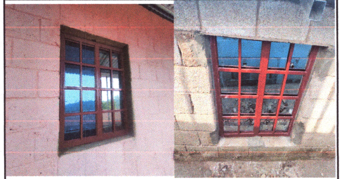
FOTO 2: instalación de ventanas,
