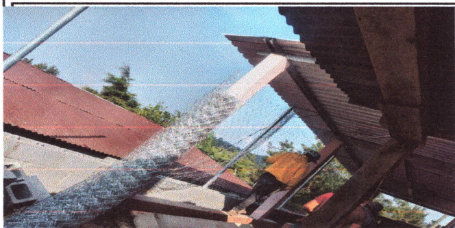
Foto1: Iniciando a instalar la malla metalica
