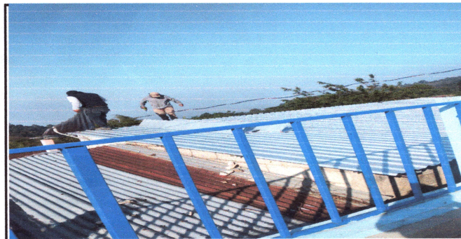
Foto: 5 colocacion de la lamina,
