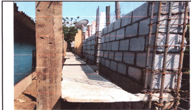
foto 2. Reconstruccion muro en un 70%.
