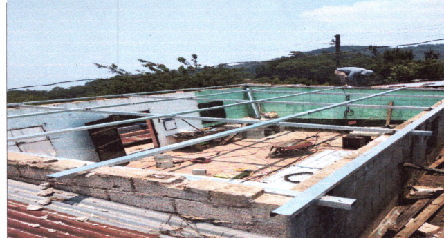
Foto4: soldadura de estructuta metalica
