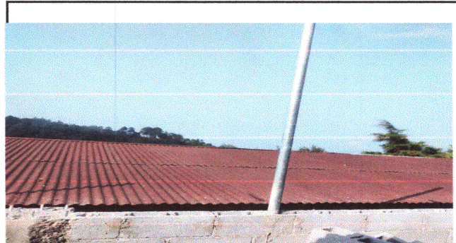
Foto 6: fundicion de tubos para la malla.
