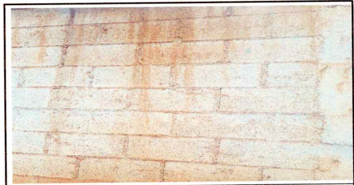
Foto: 6 Se evidencia pintura de paredes deteriorada.
