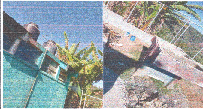
Foto7: REPARACION Y MANTENIMIENTO DE CISTERNAS/ DEPOSITO DE AGUA
