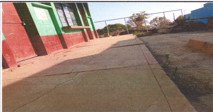
Foto: 5 LOSA DE PATIO
