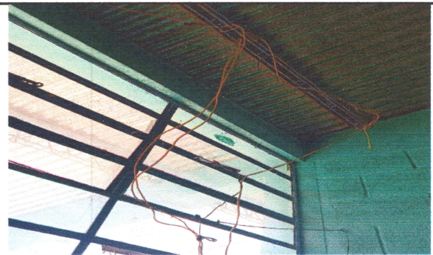
Foto: 6 REPARACION DE SISTEMA ELECTRICO
