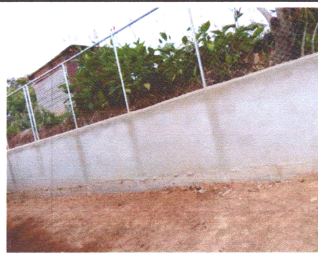
Foto4: PINTURA EN MUROS INTERIOR Y EXTERIOR
