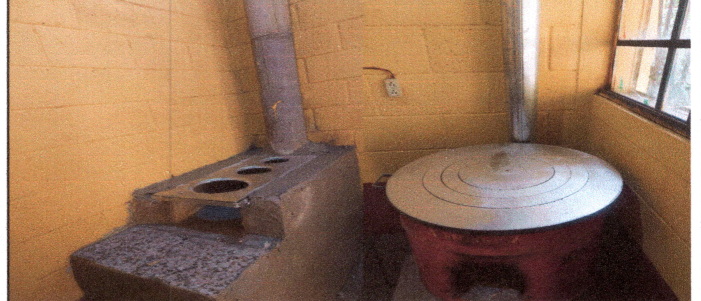
Foto 11: Reparación de área de cocina.
