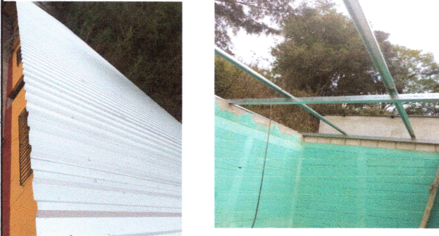
FOTO 1: Cubierta de lámina. FOTO 2: Estructura de techo.
