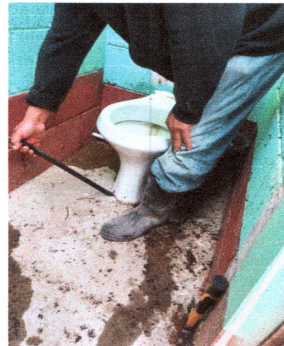
Foto 7: Sustitución de servicios sanitarios. FOTO 8: Sustitución y mantenimiento de portones.
