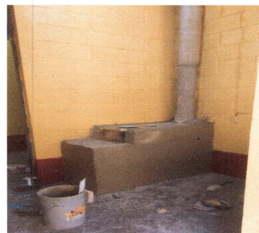
Foto 11: REparación o sustitución de cocina.
