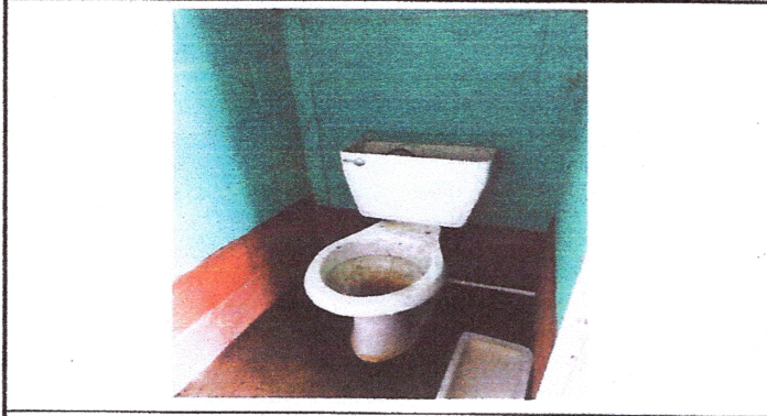
Foto 7: Sustitución de baño
