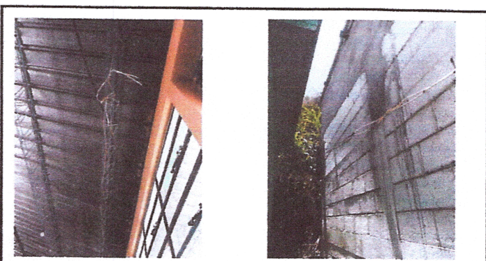
Foto 10: Reparación del sistema eléctrico
