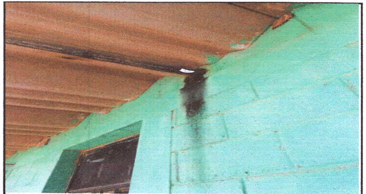
Foto 2: Estructura de techo
