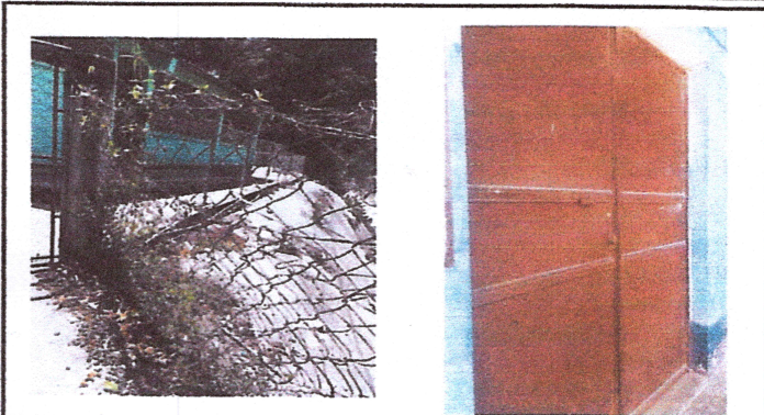
FOTO 8: Sustitución y mantenimiento de portones
