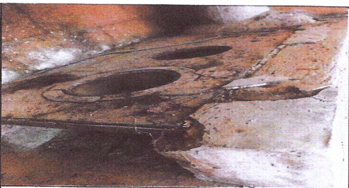
Foto 11: Reparación de cocina
