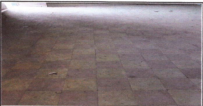
Foto 5: Sustrucción de piso
