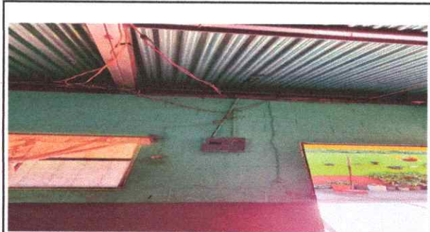
Foto 10: Sustrucción de cableado, tomacorrientes y bombillas led con interruptor
