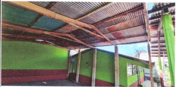
Foto 3: Sustitución de estructura de techo del patio techado para actividades
