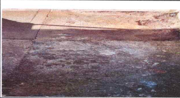
Foto 9: Reparación de losa de patio
