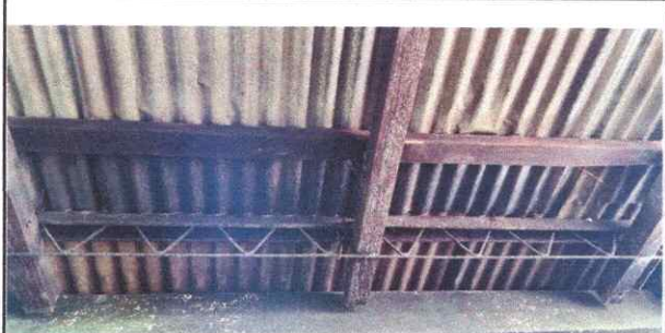
Foto 12: Sustrucción de estructura de techo de cocina
