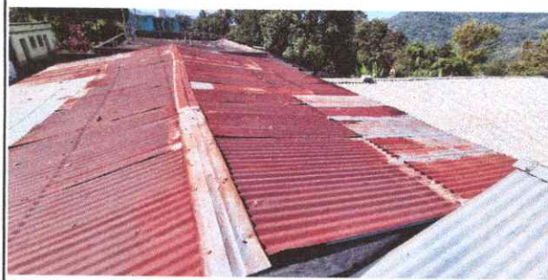
Foto 2: Sustitución de lamina acanalada legitima y capote del patio del corredor para actividades
