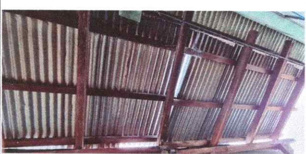
Foto 11: Sustrucción de lamina acanalada legitima calibre 28 de cocina
