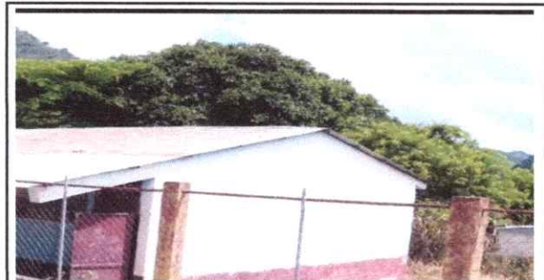
Foto 3: Pintura en muros interior y exterior
