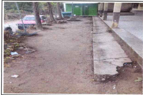
Foto 8: Losa de patio
