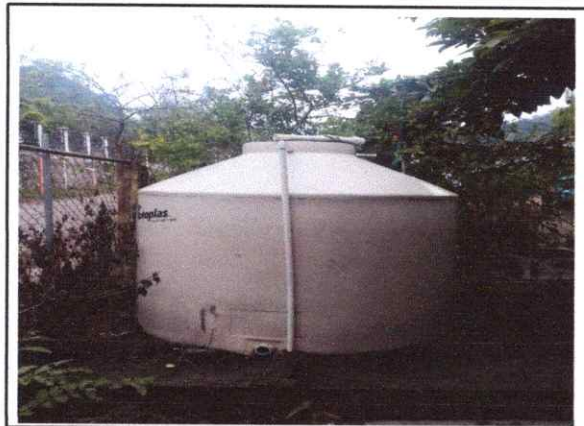
Foto 9: Reparación y mantenimiento de cisternas/deposito de agua
