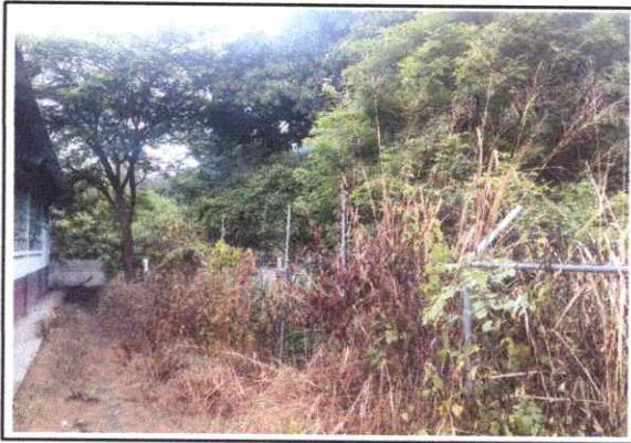
Foto 7: Cerco o muro perimetral
