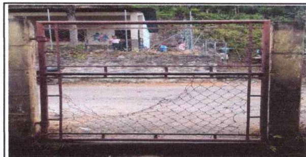
Foto 5: Mantenimiento a portones
