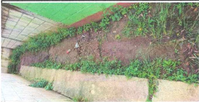
Foto 3: LOSA DE PATIO
