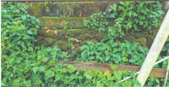
Foto 5: SUSTITUCION DE MURO DE CONTENCIÓN
