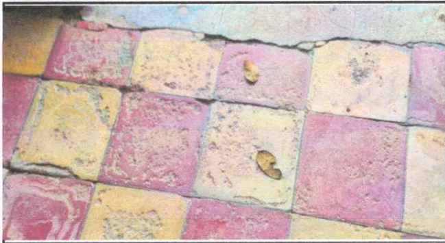
Foto1: SUSTITUCION DE PISO
