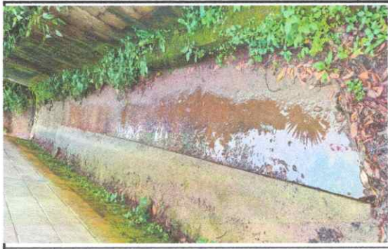
Foto 2: REPARACION DE CERNIDO Y REOELLO EN PAREDES
