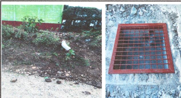
Foto 4: Posterior la tubería del drenaje porque cuando llueve se rebalsa la reposadera porque el diametro del tubo muy pequeño
