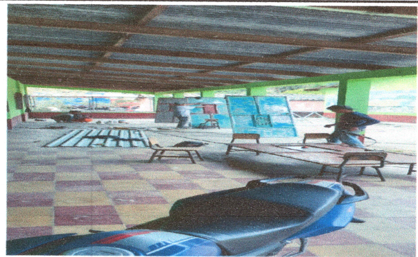
Foto 10: Avance en pintura de puertas
