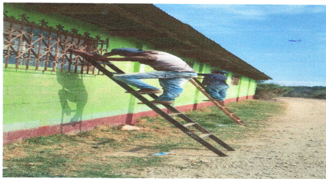
Foto 9: Avance de ventanas
