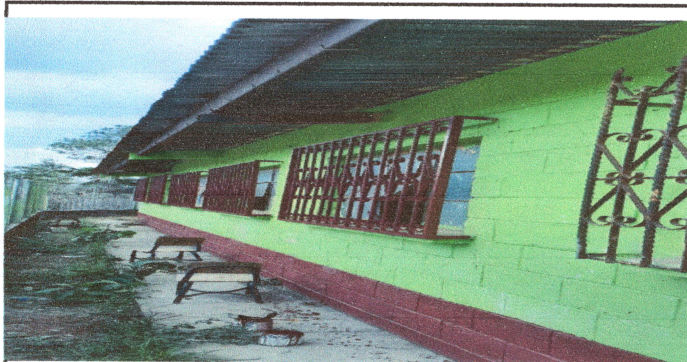
Foto 11: Avance pintura de exterior
