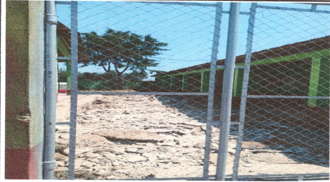
FOTO 7: Avance del portón y pintarlo
