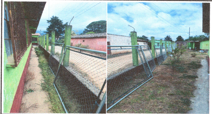
FOTO 8: Avance de todo el cerco perimetral
