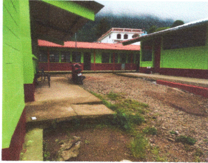
Reparación de ventnas
