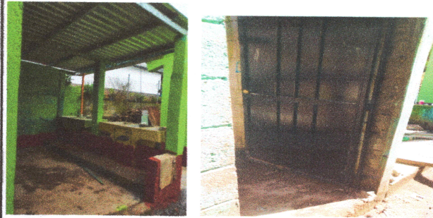
Reparación de cocinas, pilas y techo
