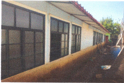
Reparación de balcones y puerta
