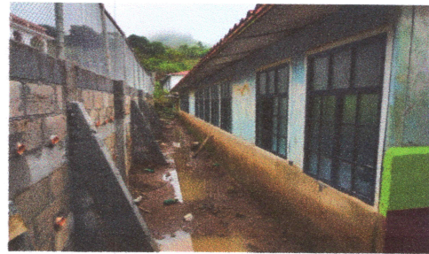
Reparación de muro de contención
