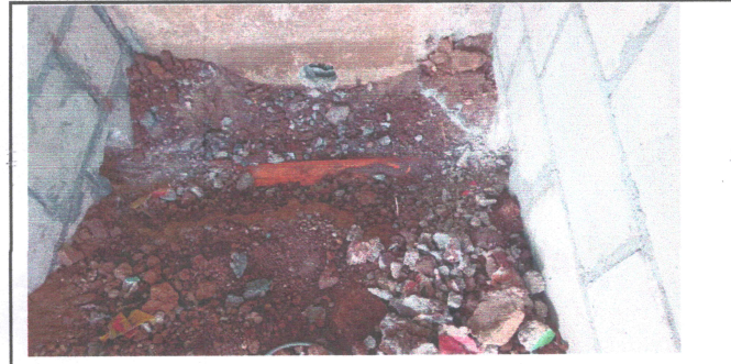
Foto: INSTALACION DE DRENAJES Y TUBERIA DE ENTRADA DE AGUA
