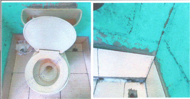
Foto3: TAZAS NUEVAS Y LEVANTAMIENTO DE PAREDES
