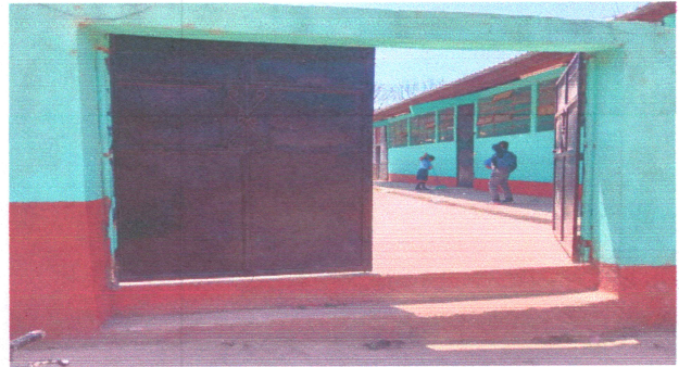
FOTO 2: PINTURA EN MUROS EXTERIOR
