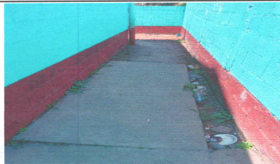
Foto 6 LOSA DE PATIO Y BANQUETA DE LA PARTE DE ATRÁS
