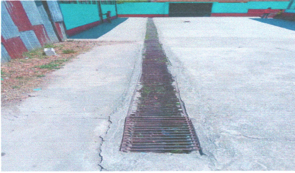
Foto1: IMPERMEABILIZACION DE LOSA DE PATIO
