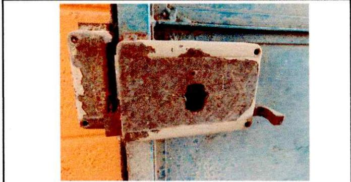
Foto 2: Puertas sustitución de 7 chapas y reparación y pintura de 2 puertas
