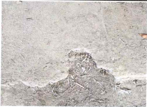
Foto 3: SUSTITUCIÓN LOSA DE PATIO INCLUYE BASE, DEMOLICIÓN, FUNDICION Y ACABADOS
