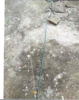
Foto 2: SUSTITUCIÓN LOSA DE PATIO INCLUYE BASE, DEMOLICIÓN, FUNDICION Y ACABADOS
