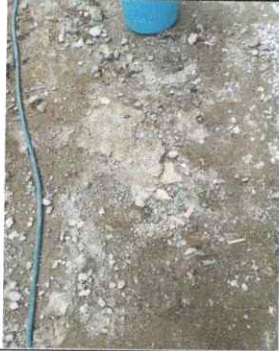
Foto 1: SUSTITUCIÓN LOSA DE PATIO INCLUYE BASE, DEMOLICIÓN, FUNDICION Y ACABADOS
