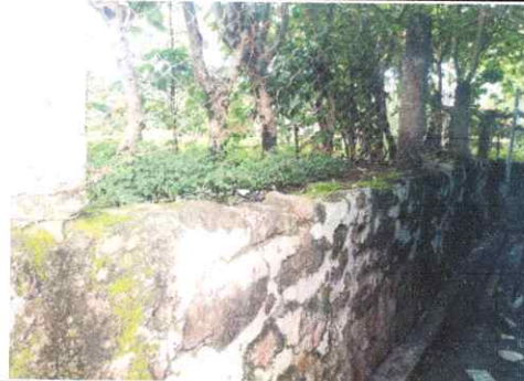
Foto 4: SUSTITUCIÓN MURO DE BLOCK PINEADO INCLUYE TUBOS DE DRENADO
