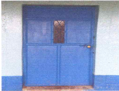
Reparación de puertas
