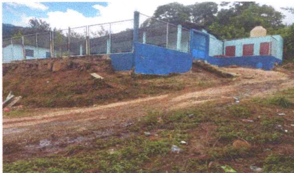
Reparación de muro perimetral
