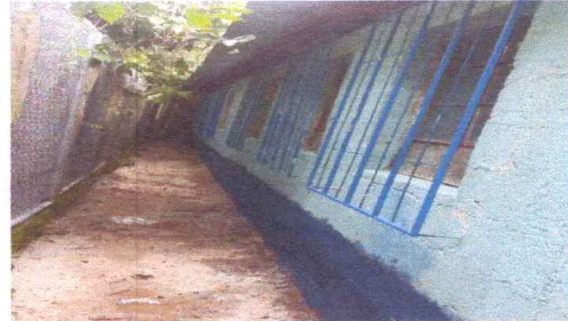
Reparación de ventanas
