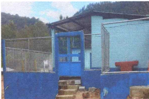
Mantenimiento y reparación de portón
