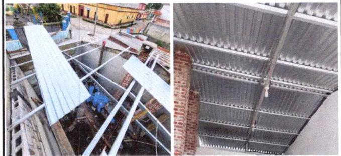
Foto 2: Reemplazo de estructura metálica. Techo de cocina. Después. Renglón No. 2
