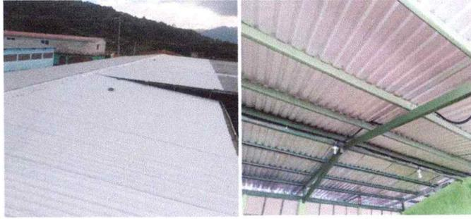
Foto 1: Reemplazo de cubierta de lámina. Cocina y 5 aulas. Después. Renglón No. 1
