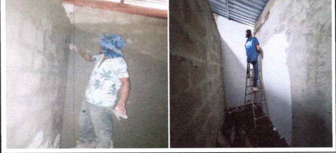
Foto 6: Reparación de repello y cernido de paredes. Cocina. Durante. Renglón No. 21
