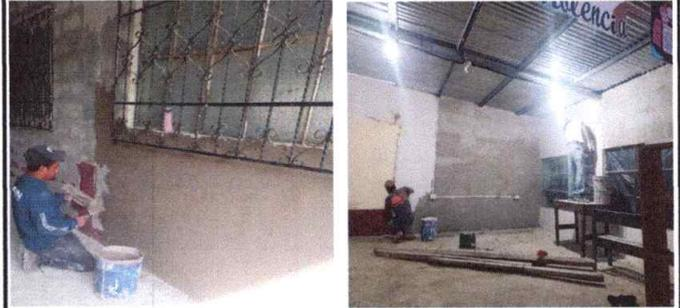
Foto 8 : Reparación de repello y cernido de paredes.Durante. Área corredor y escenario. Renglón No.21
