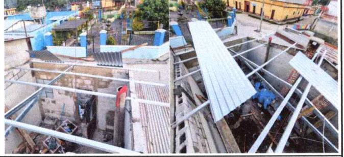
Foto 2: Reemplazo de estructura de techo, cocina.. Durante. Renglón No. 2
