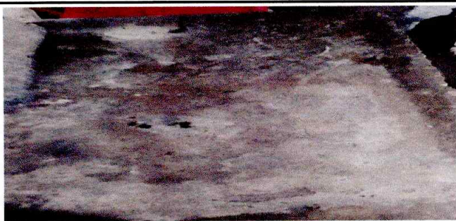
Foto 5: Se observa mesa en mal estado (área cocina)
