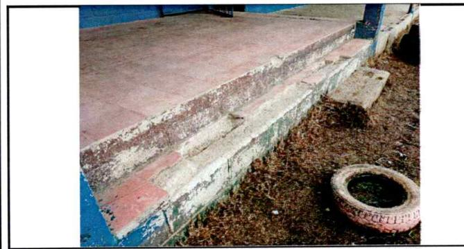
Foto 5: VISTA AMPLIA DEL MAL ESTADO DEL PISO DEL PASILLO PRINCIPAL Y ESCENARIO DE LA ESCUELA.
