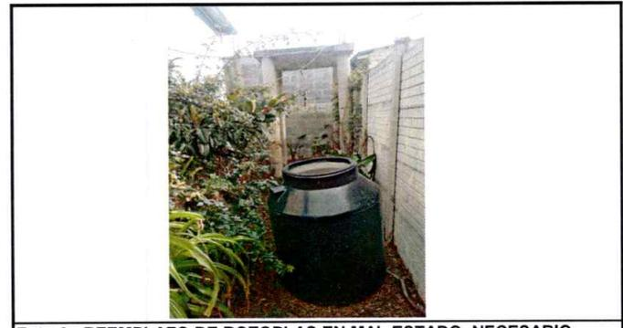
Foto 6: REEMPLAZO DE ROTOPLAS EN MAL ESTADO, NECESARIO PARA EL ABASTECIMIENTO DE AGUA
