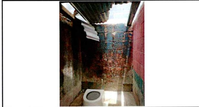
Foto 1: CUBIERTA DE LÁMINA Y ESTRUCTURA DEL TECHO DE SANITARIOS EN MAL ESTADO
