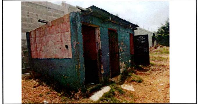
Foto 2: VISTA EXTERNA DE LA ESTRUCTURA DEL TECHO DE LOS SANITARIOS EN MAL ESTADO
