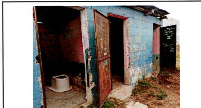
Foto 3: PUERTAS DE SANITARIOS EN MAL ESTADO Y FALTANTES
