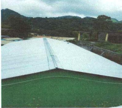
Foto 1: cubierta de lamina
