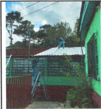
Foto1: Cambio de Lámina
