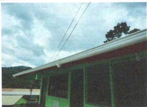
Foto3: Sustitución de Canales
