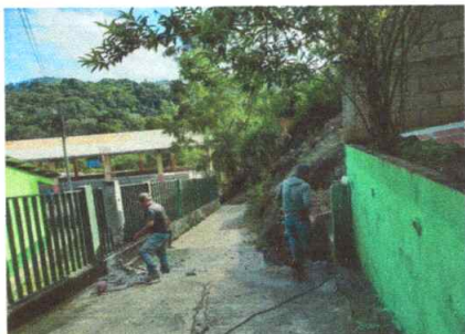
Foto:5 Mantenimiento Portón
