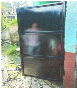
FOTO 2: Cambio de Puertas
