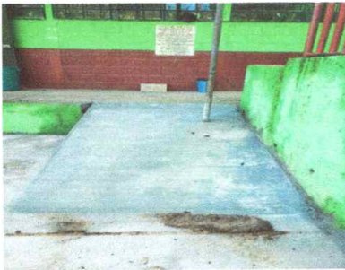
Foto 11: Losa de Patio
