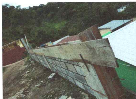
Foto: 6 Levantamiento muro
