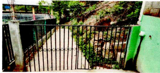
Foto 6: Cambio de Portón
