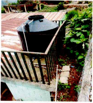
Foto 9: Reparación depósito de agua
