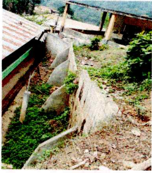
Foto 7: Levantamiento Muro Perimetral
