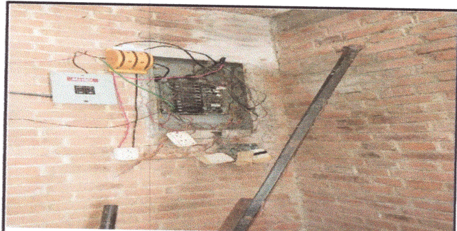
Foto: 6 REPARACION SISTEMA ELECTRICO CAMBIO CAJAS FLIPONES, TOMACORRIENTES, PLAFONERAS, SWICH, BOMBILLAS DE AULAS Y PASILLOS
