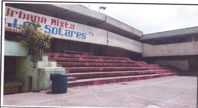
Foto4: PINTURA DE MUROS, EXTERIORES,INTERIORES, FACHADAS, PASILLOS, GRADAS, PUERTAS Y PORTONES.
