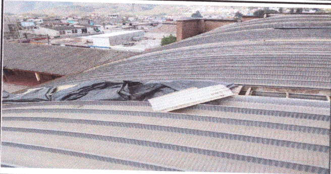
Foto1: SUSTITUCION DE CUBIERTA DE LAMINA TRAGALUZ DEL TECHO DEL AUDITORIUM DE LA ESCUELA
