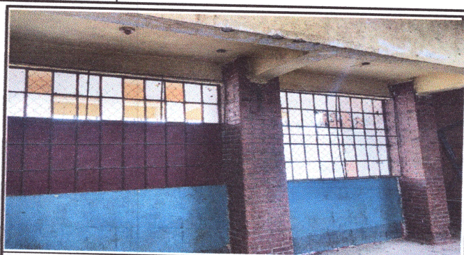
FOTO 2: SUSTITUCION DE VIDRIOS ROTOS EN VENTANALES DE AULAS Y AUDITORIUM DE LA ESCUELA.
