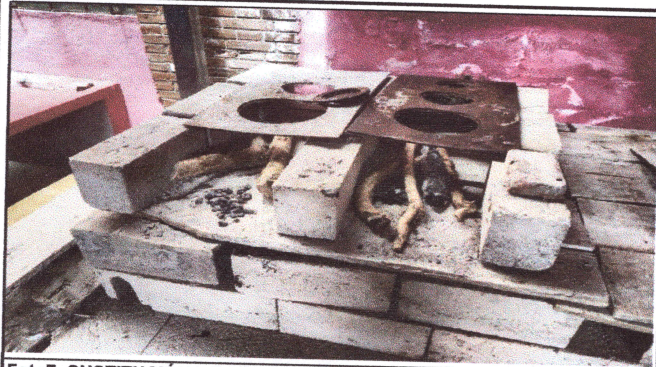
Foto7: SUSTITUCIÓN DE ESTUFA RURAL DE 2 ORNILLAS POR ESTUFA RURAL DE 3 ORNILLAS, Y CHIMENEA ELABORADA CON LADRILLO.
