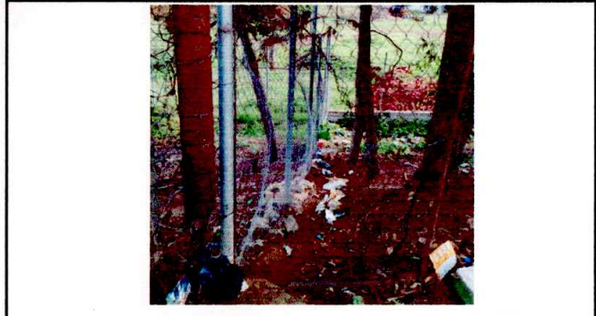
Foto 1: sustitucion de muro perimetral en mal estado
