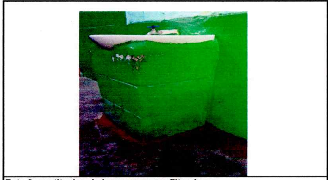
Foto 3: sustitucion de lavamanos con filtraciones
