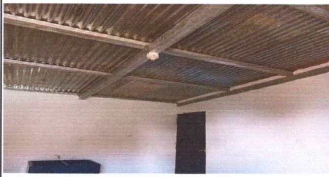
Foto 1: Se evidencia finalización de estructura de techo dañado
