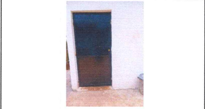
Foto 2: Evidencia de finalización de reparación de puerta en mal estado
