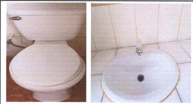
Foto 3: Finalización de reparación de baño y lavamanos
