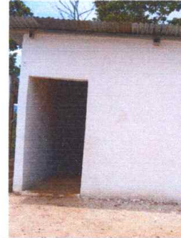
Foto 2: Se observa la reparación para instalacion de puerta
