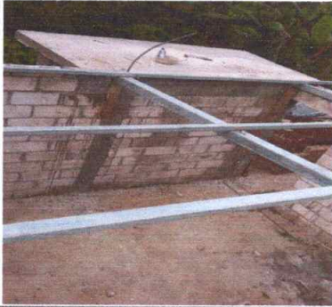
Foto1: Se evidencia instalación de costanera para techo
