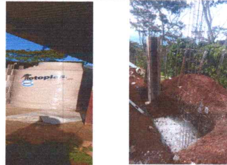
Foto 6: Se observa reparación de cisterna
