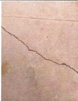
Foto 5: Se evidencia losa de patio en mal estado
