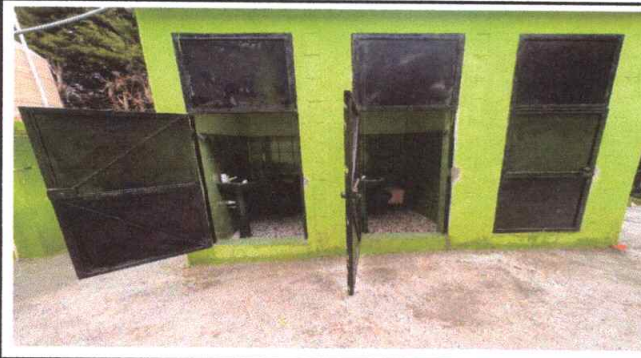
Foto 3: Se observa el remozamiento de baños terminado.
