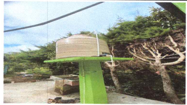
Foto 4: Se observa el trabajo de compostura para el deposito de agua finalizada .
